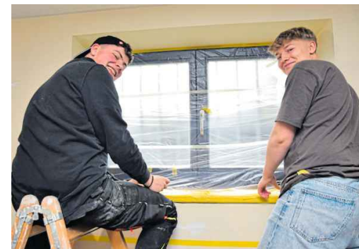
David Hassenewert (l.) und Finn Pickert von der Kolpingjugend sorgen dafür, dass keine Farbkleckser auf die Fenster kommen.
